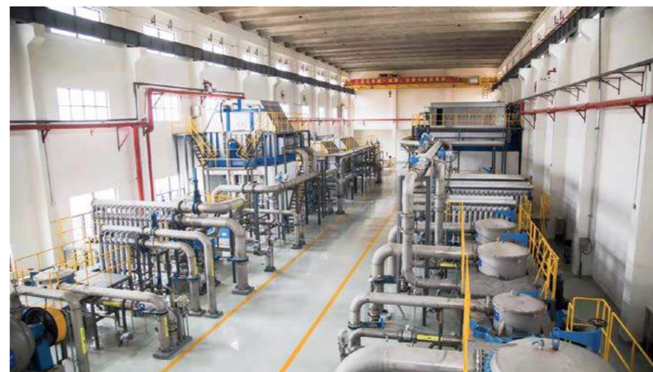
浙江金励40万吨灰板纸项目现场
