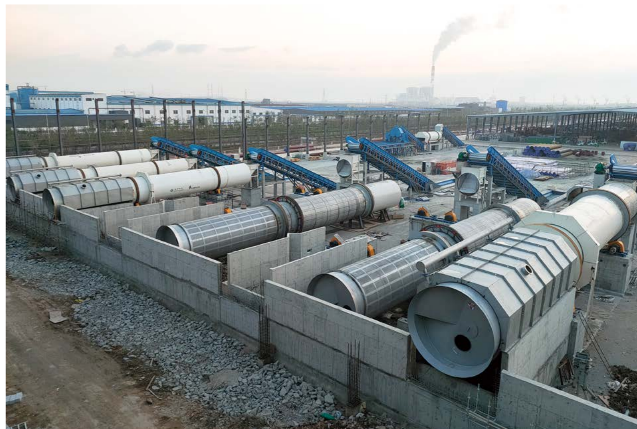
江苏金田100万吨高档灰板纸项目现场
